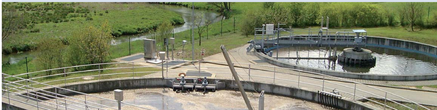
▲ Kapazitätserhöhung der Biologie (aerob), Deutschland, Velburg
